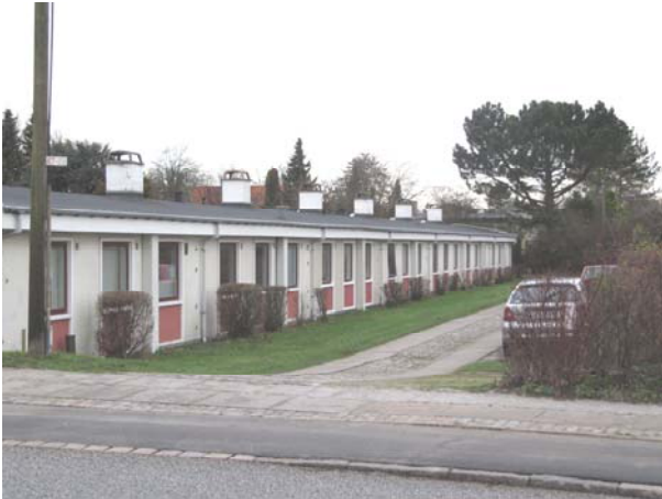
Eksempel på rækkehuse mod fællesarealet. Indgangen sker fra havesiden. Bebyggelsens enkelthed, de ens farver og skorstene er karakteristisk for bebyggelsen.
